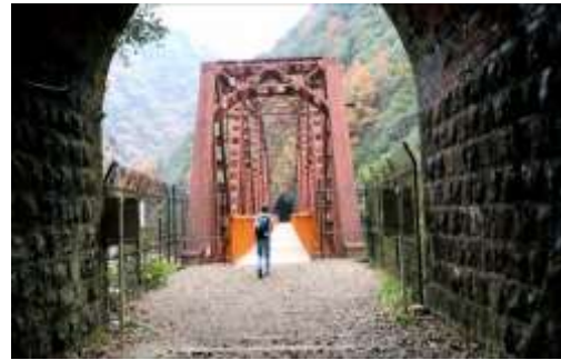
トンネル抜けて鉄橋渡り
